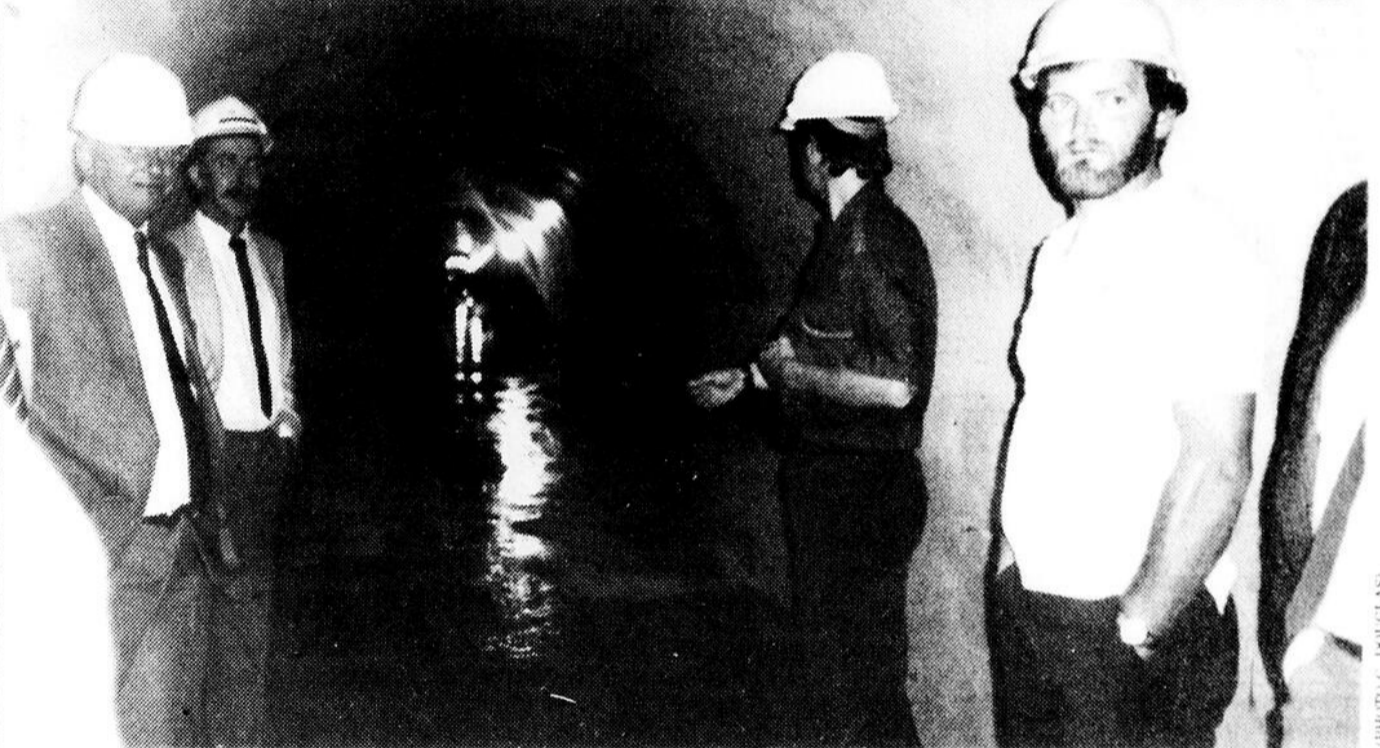
La Ville de Rivière-du-Loup vient de franchir une première étape importante dans son projet d'assainissement des eaux usées, en procédant à l'ouverture d'un tunnel de béton menant à l'usine de traitement.
