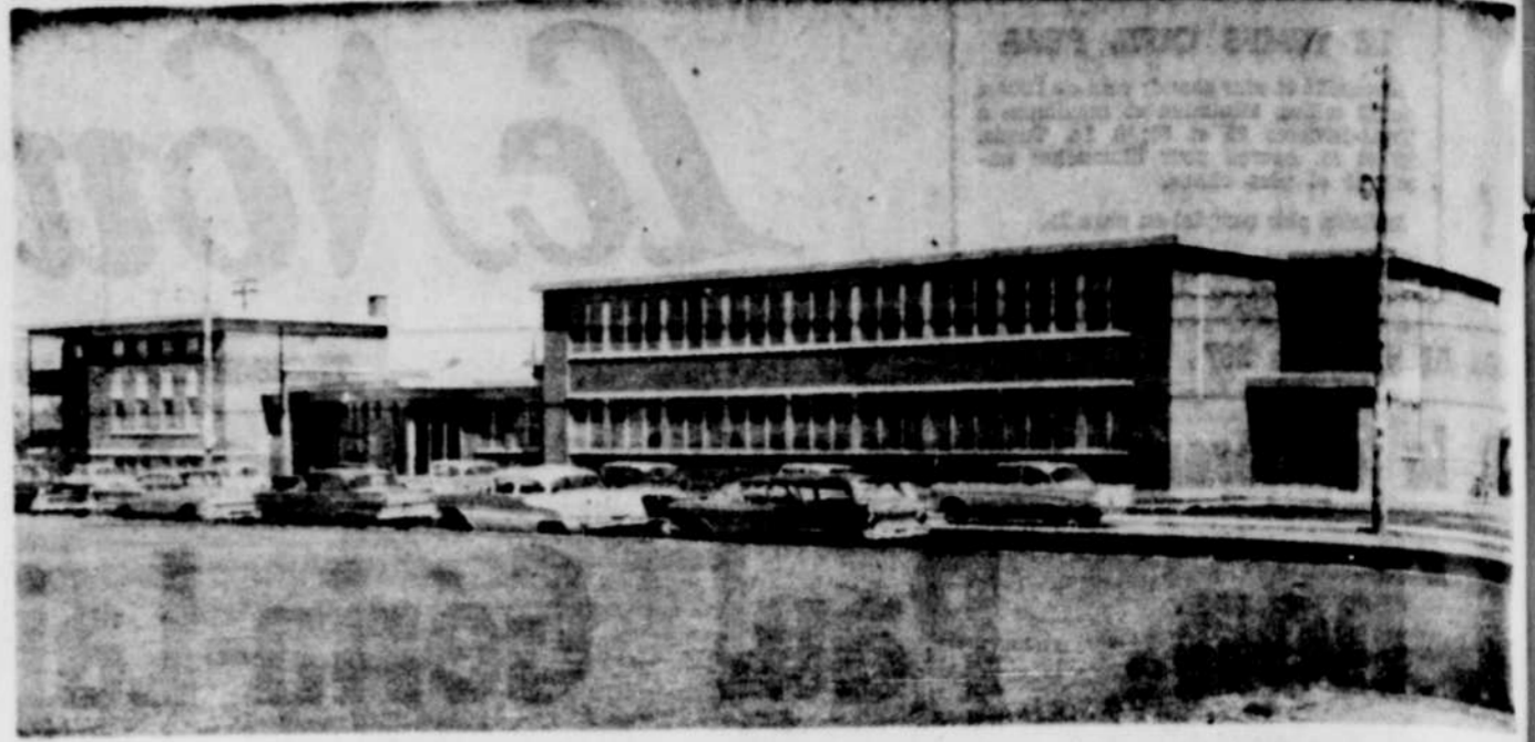
L'ECOLE NOTRE-DAME-DU-CAP, à l'angle des rues Massicotte et Montplaisir, au Cap-de-la-Madeleine qui sera bénite dimanche à 4 hres par Son Excellence Mgr Georges-Léon Pelletier, évêque du diocèse de Trois-Rivières. Construite en 1958, elle s'élève juste en face de l'école supérieure Assomption.
