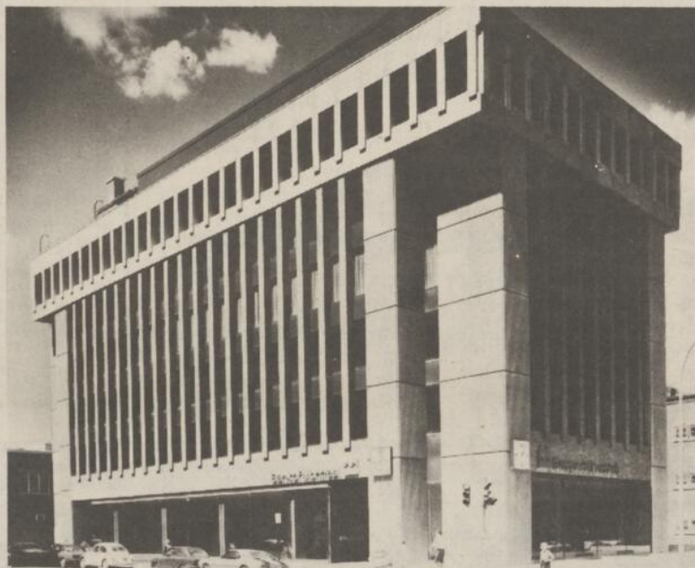
Immeuble de bureaux à Westmount (Qué.)
