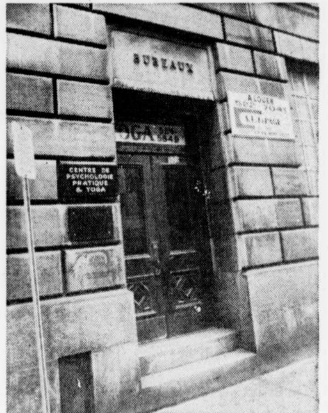
C'est au 509 du boulevard Charest que le Crédit social aura pignon sur rue à Québec.
