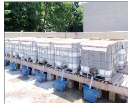
Photo 4 – Parcelles stabilisées et traitées avec les systèmes de récupération des eaux de ruissellement et d'infiltration
