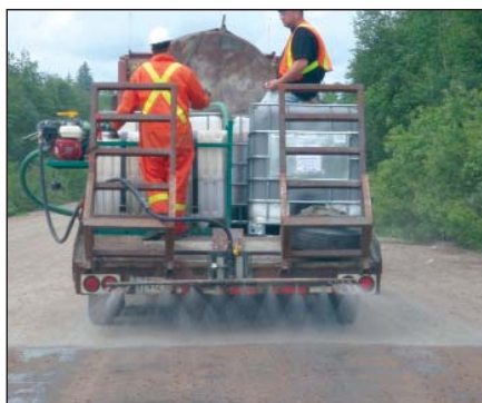
Photo 1 – Travaux d'épandage de produit abat-poussière à l'été 2008
