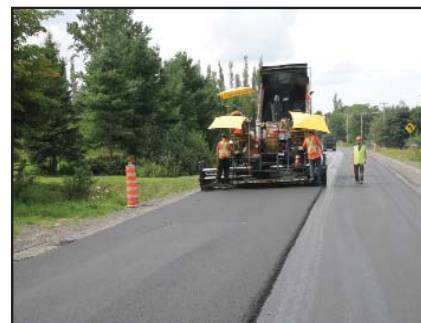
Photo 1 - Enrobés tièdes (Procédé CMW) Route 132 St-Antoine-de-Tilly. L'enrobé a été mis en place aux environ de 125°C. On note l'absence de fumée.
