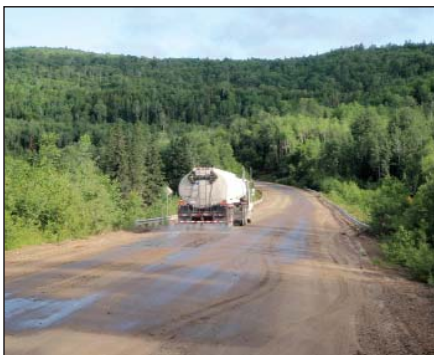
Photo 3 – Mise en place de produits abat-poussière avec un camion d'épandage à l'été 2009
