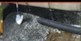
RÉPARATION DE DRAIN FRANÇAIS
