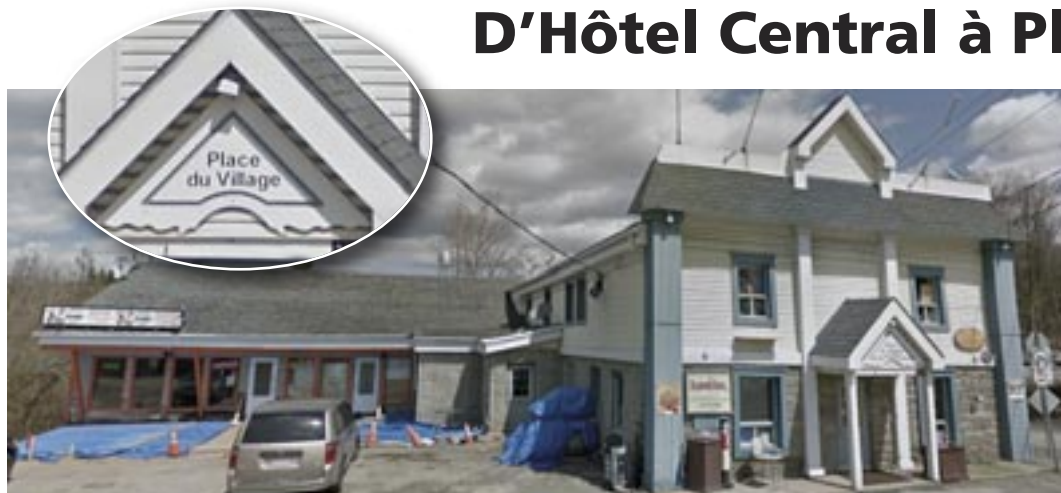
Place du Village, au cœur du village de Saint-Hippolyte. Bâtiment malheureusement complètement détruit par le feu le 2 avril.
