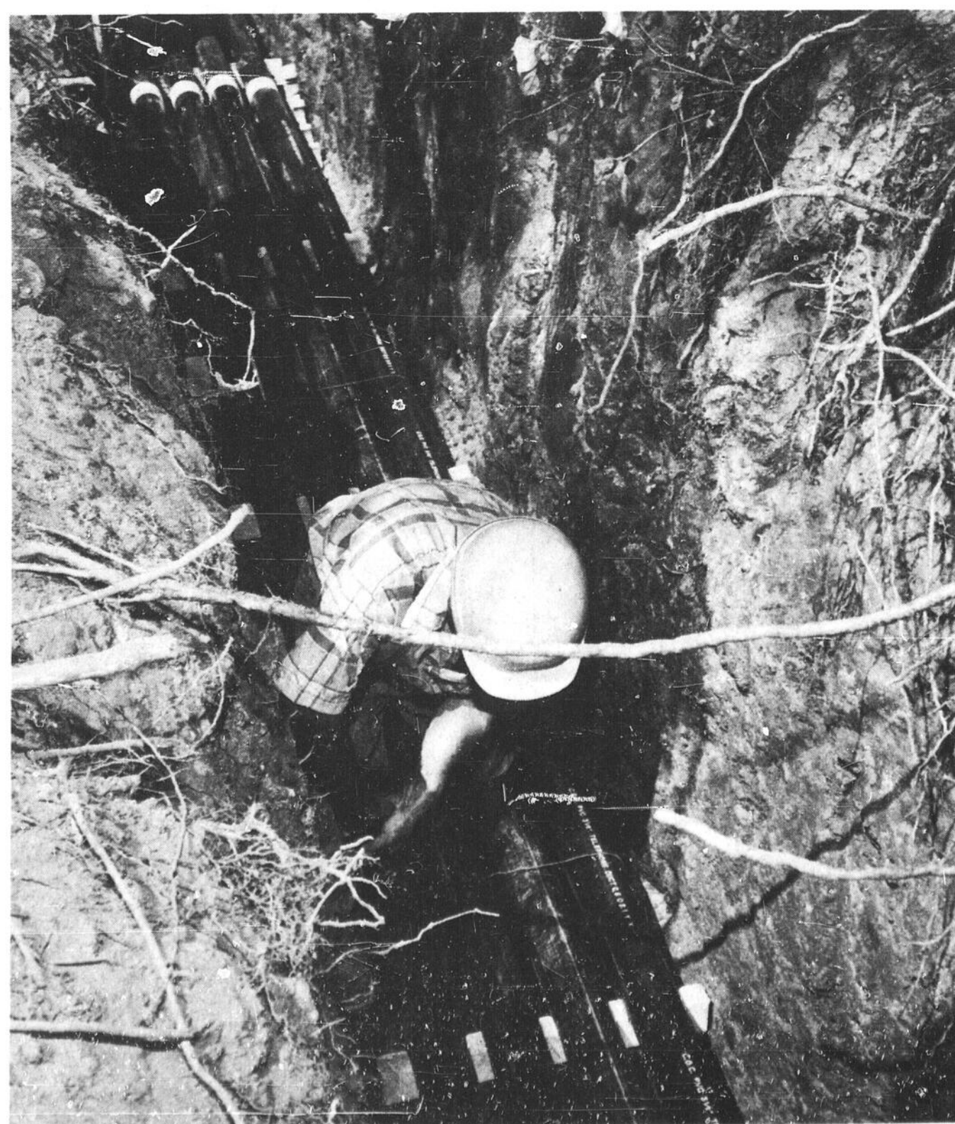
Dépendant du secteur, il peut être nécessaire de placer jusqu'à 60 conduits téléphoniques dans une seule tranchée pour répondre aux besoins présents et futurs des abonnés.
