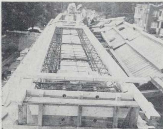
Coffrages des panneaux des murs.
