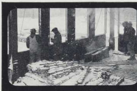
Erection même pendant les intempéries.
